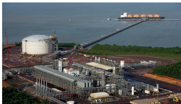
Fig. 3 LNG Liquefaction Plant [3]
