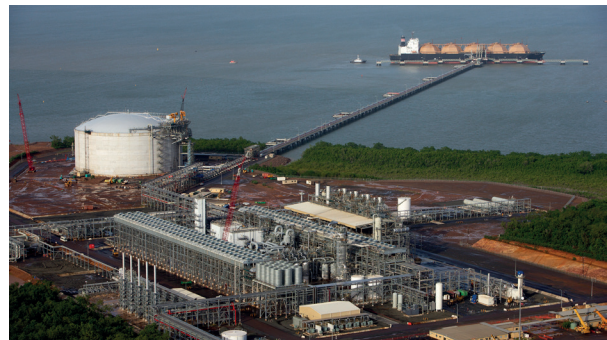
Fig. 3 LNG Liquefaction Plant [3]
